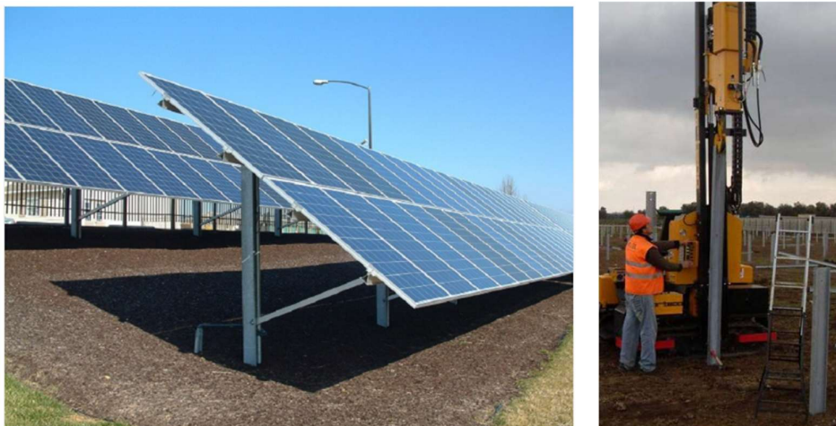
Figur 11, solpanelsinstallation med pålat fundament, samt typisk utrustning för pålning.
