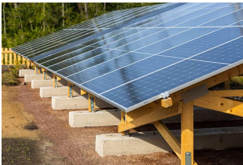
Figur 12, gravitationsfundament i betong, OX2 pilotanläggning i Möckelö.
