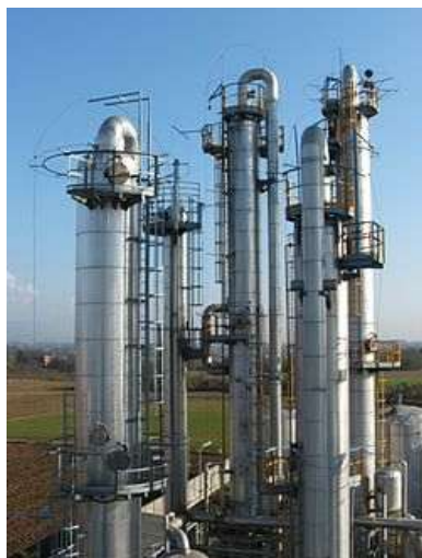
Figur 3, destillationskolonner för kontinuerlig destillation i ett raffinaderi.
