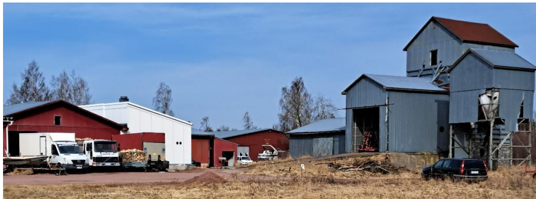
Byggnaderna på FB-området
